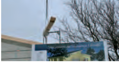
Richtfest – der letzte Balken wird gelegt
